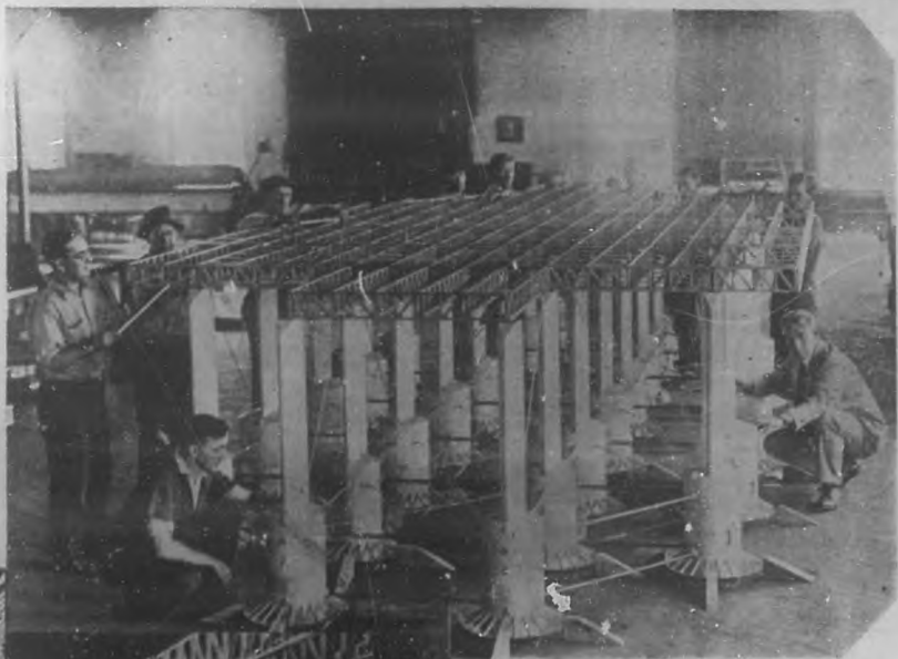
Un grupo de obreros de los talleres de Chester, en Wilmington, Delaware, dando los últimos toques a la estructura del aerodromo marítimo que próximamente será botado al agua y emplazado en Cambridge, Md., para uso de aviadores transatlánticos. Este refugio para los audaces pilotos que se lanzan a la conquista del traidor Atlántico, ha sido diseñado y construido bajo la dirección de Mr. Edward R. Armstrong.
